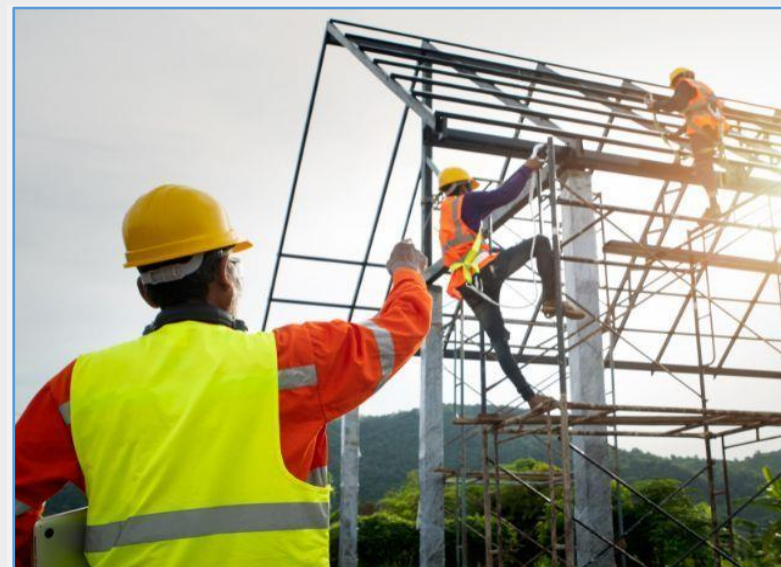
Figura 2 Sector de la construcción. Montaje de estructuras metálicas. (Fuente: www.coordinacae.com )
