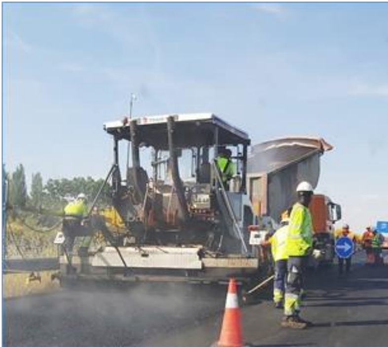
Figura 1. Tareas de asfaltado (Fuente propia)
